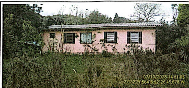
Vista Fundos da área da escola
